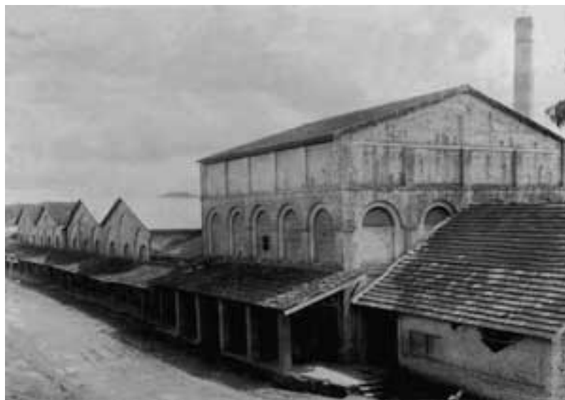
Figura 6: Sede da Kaigai Kogyo Kabushiki Kaisha
