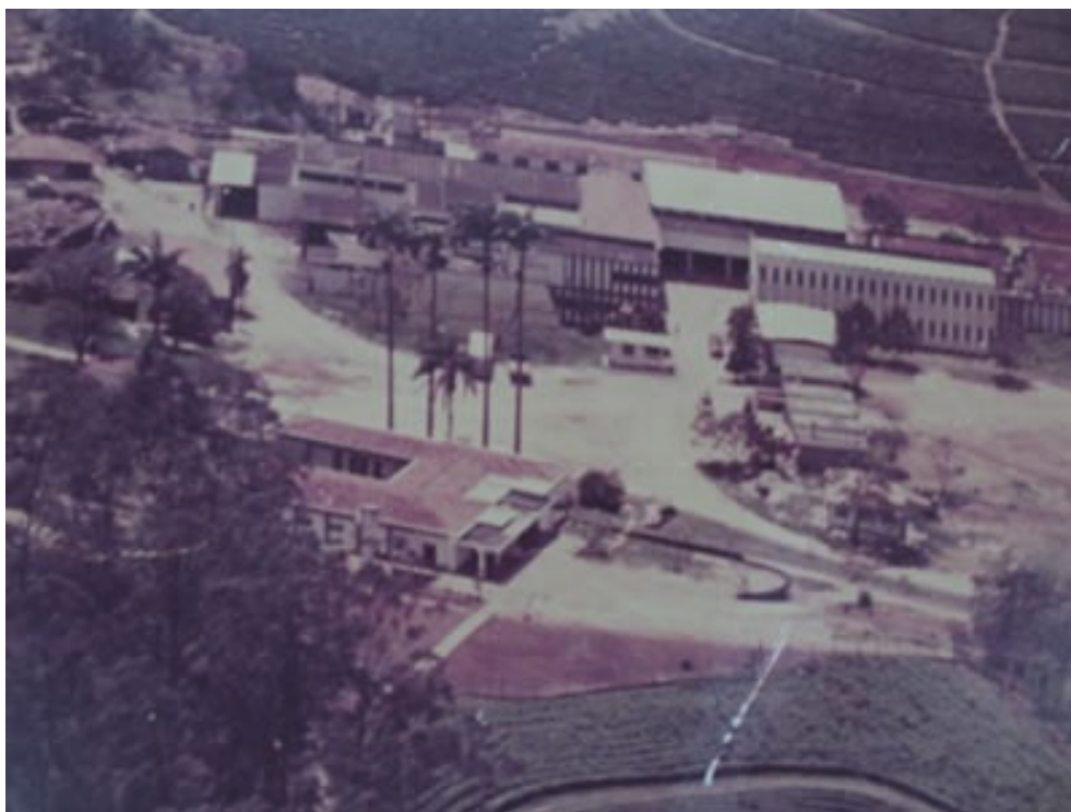
Figura 13: Fábrica de Chá em Registro
